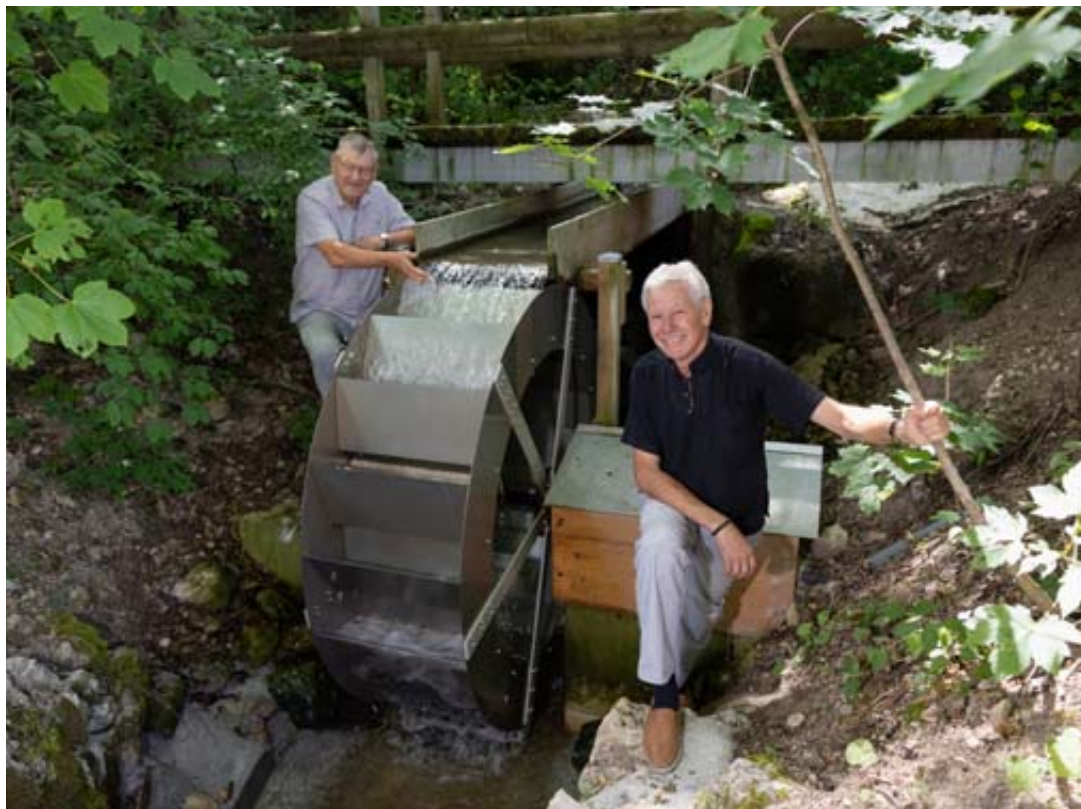
Daniel Henry (à gauche) et Jean-Marc Fischer entourent la nouvelle roue à augets installée l'automne dernier sur une dérivation du canal d'alimentation du Moulin de Bayerel.
